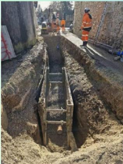
Travaux rue du village
